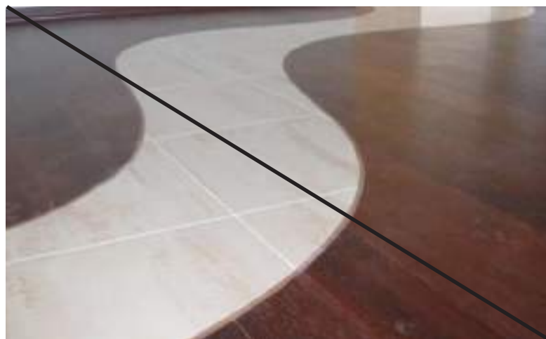
Плохо Узорные стыки из разных материалов
